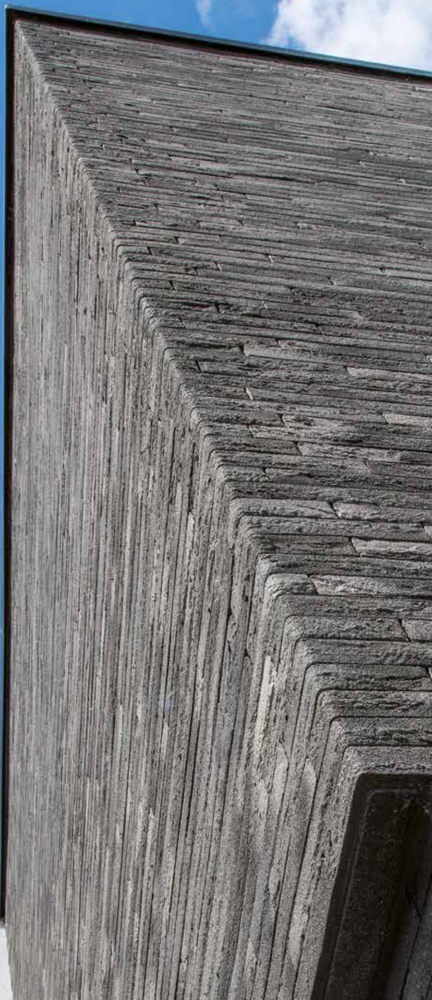
El Sistema de plaquetas "Meldorfer" puede ser instalado sobre la capa de armadura de los Sistemas de Aislamiento Térmico Exterior "Capatect", compatible con armaduras de naturaleza orgánica o mineral. En el caso de instalación sobre armaduras minerales es necesario aplicar una capa de imprimación con Putzgrund 610 como retenedor alcalino que evite la aparición de eflorescencias.
