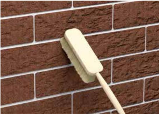
Tras un breve tiempo de secado las partes sobresalientes del mortero y posibles restos en las plaquetas se limpiarán mediante cepillado. Esta técnica proporciona a la superficie la apariencia deseada.
